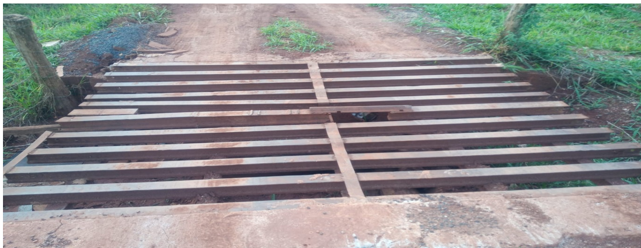
Britador BR 050 km 46
