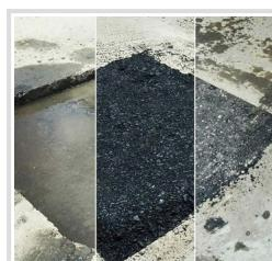
O asfalto em sacos para aplicação a frio é um produto largamente utilizado para manutenção asfáltica. Aplicado principalmente para a reparação de buracos, o asfalto frio consiste em uma mistura especial com polímeros modificados de tecnologia avançada.
