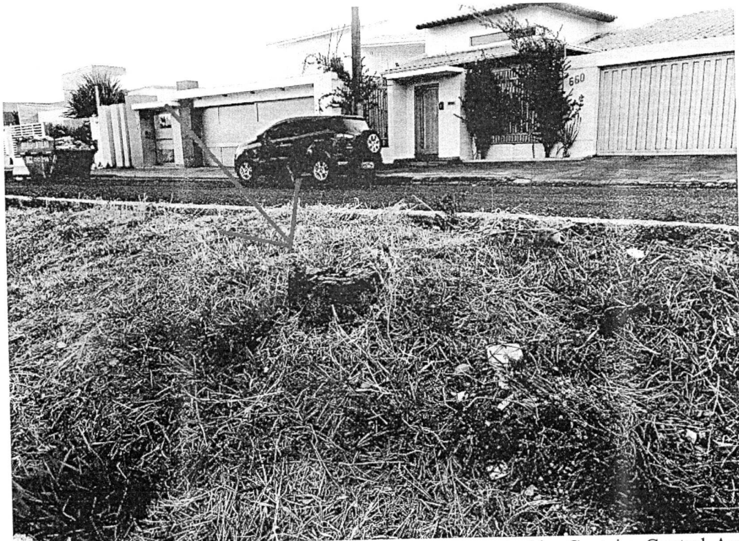
Ponto A: Local específico (imagem 3) do poço a ser construído. Canteiro Central Av. Batalhão Mauá.
