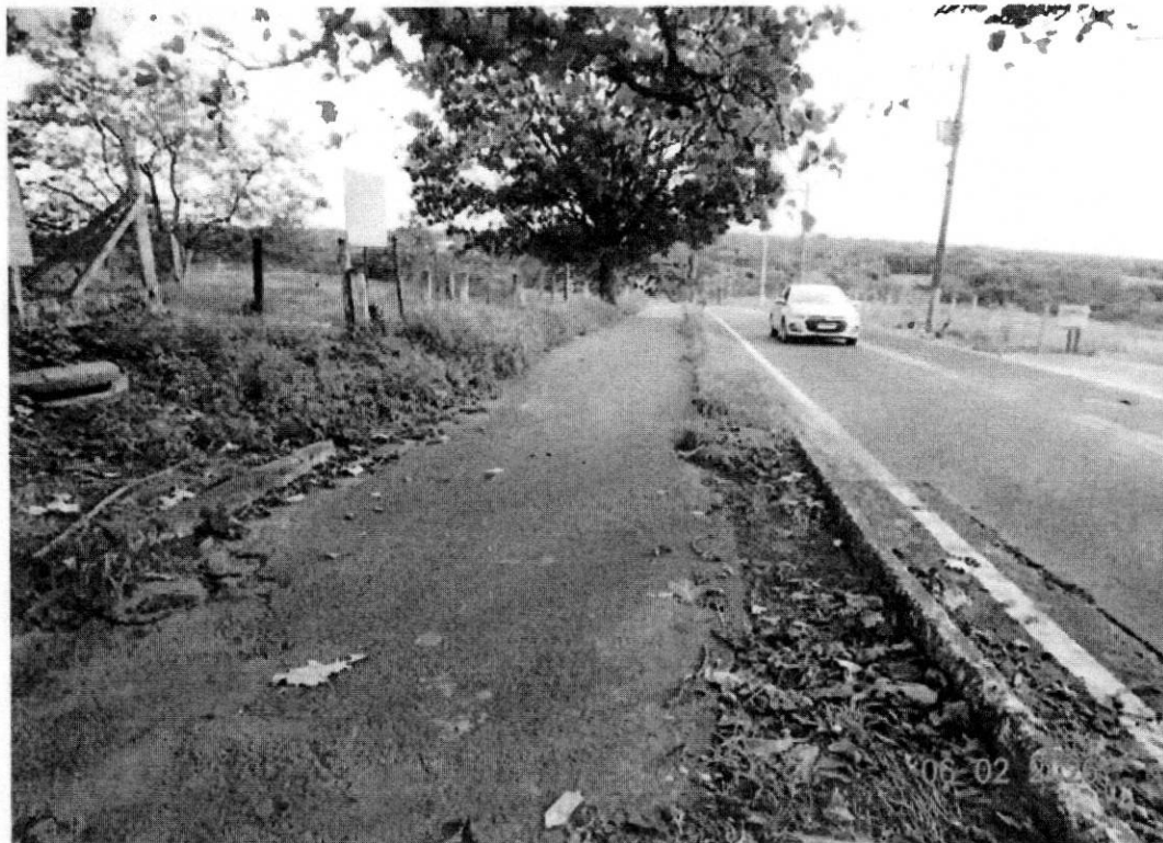
Figura 03 – vista da via sem qualquer tipo de indício de esgoto extravasando.
