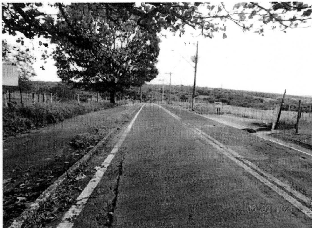
Figura 04 – Vista da montante da via sem qualquer indicativo de vazamento de esgoto.
