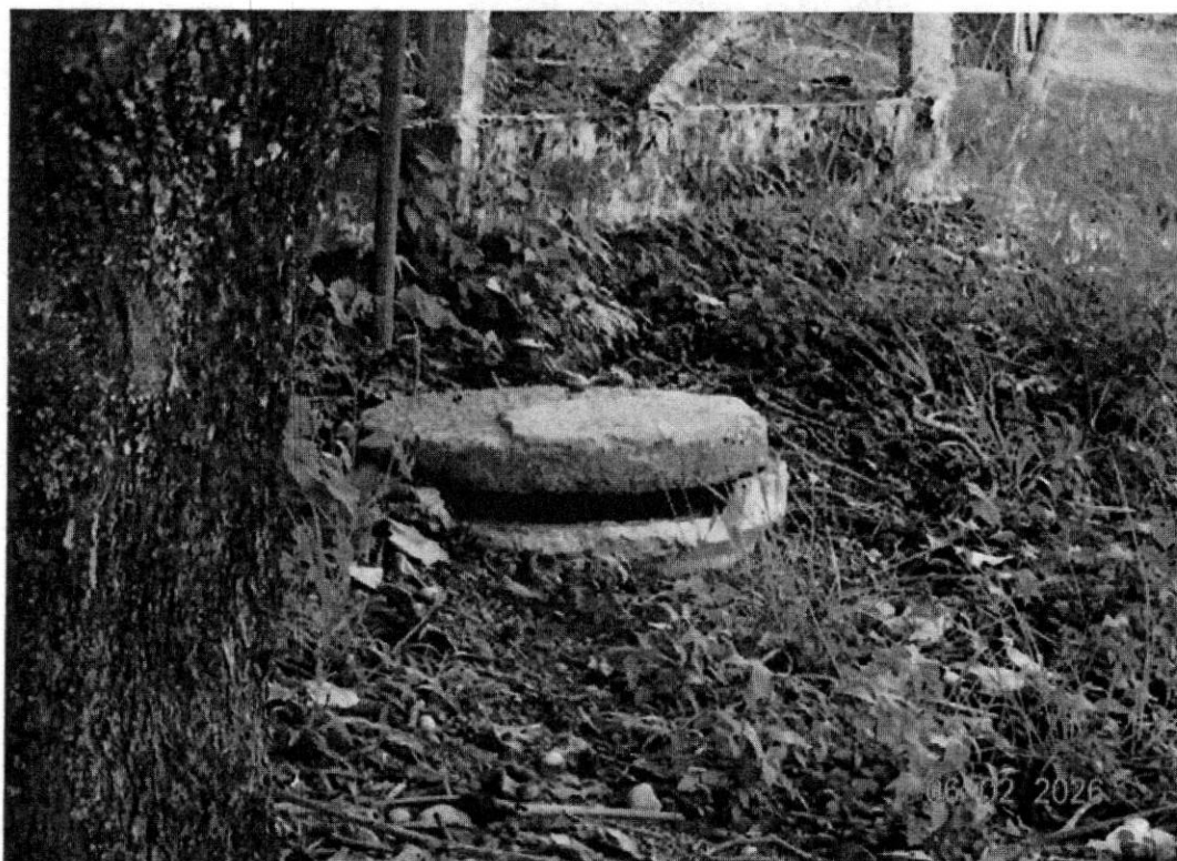
Figura 02 – vista do poço de visita sem indicativo de qualquer tipo de vazamento de esgoto.
