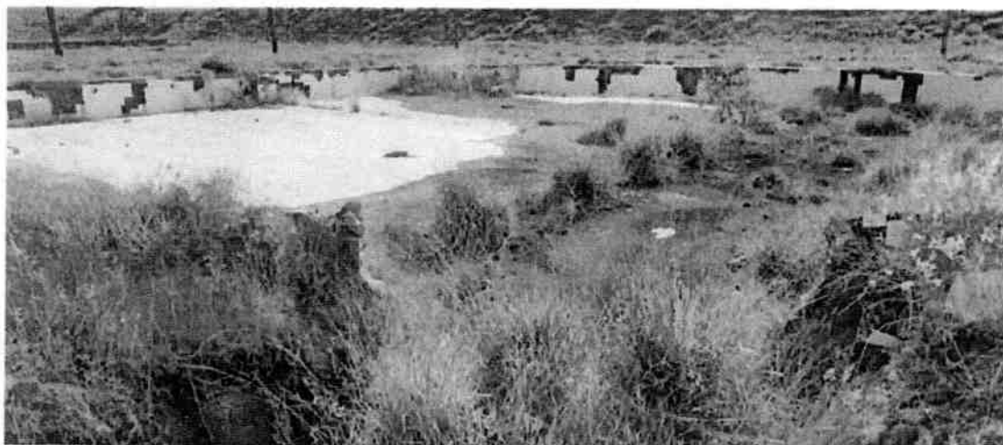
Foto 03: abertura lateral da piscina para não acumular água.
