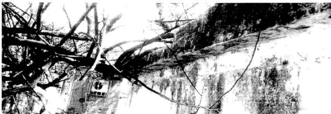
Foto 05: Deterioração e platibanda danificada pelas arvores.
